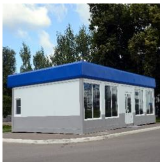
Торговый павильон, г.Тула
