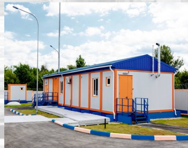
ПОДСТАНЦИЯ, г.НИЖНИЙ НОВГОРОД
