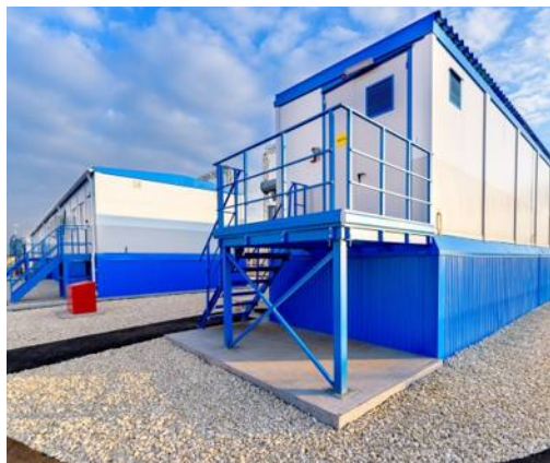
Здание ПС «Юбилейная», г.Усинск
